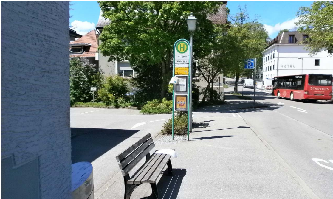
Haltestelle „Bahnhofstraße / Tiefgarage“: Überdachung und barrierefreie Ausführung fehlen.
