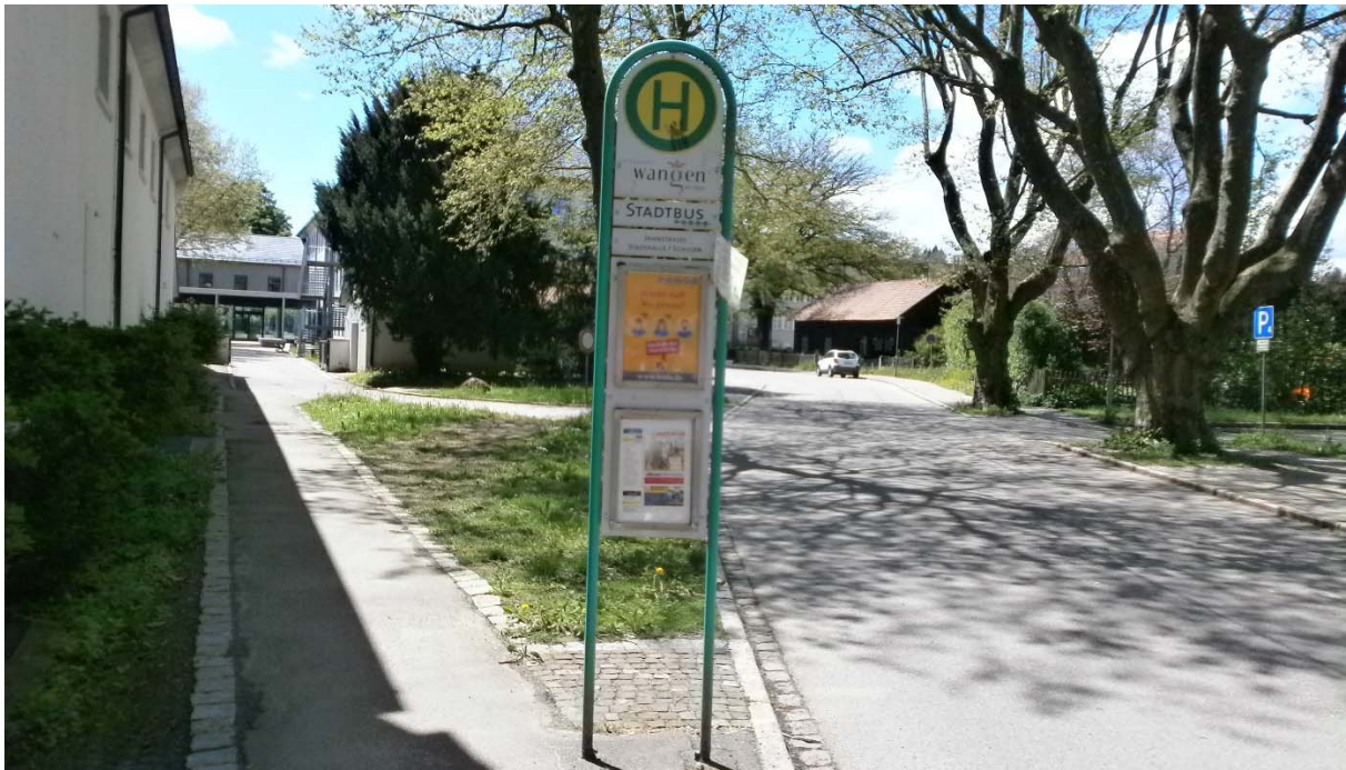
Haltestelle „Stadthalle / Schulen“: Hier fehlt es an allem; völlige Neugestaltung der Haltestelle.
