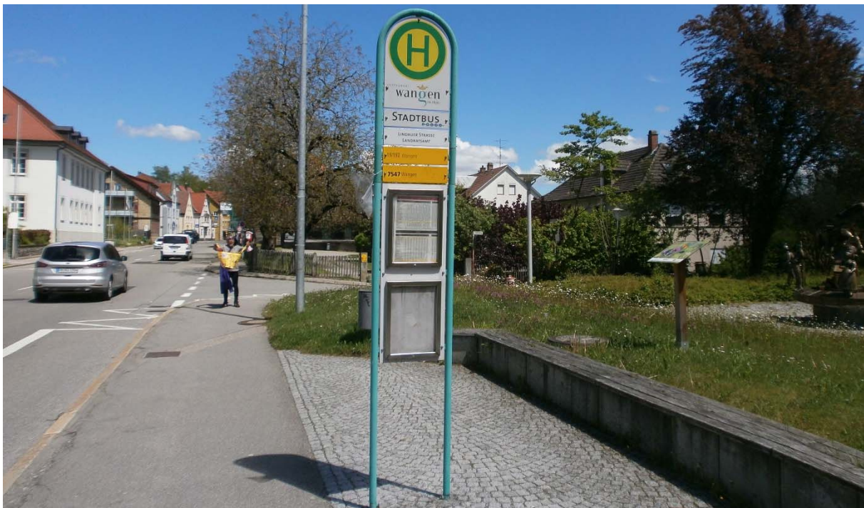
Haltestelle „Landratsamt“: Überdachung und barrierefreier Einstieg fehlen.
